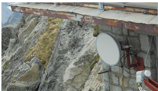
Obr. 4: Anténa na konzole na JV stene budovy SAV vedľa kuchyne.
